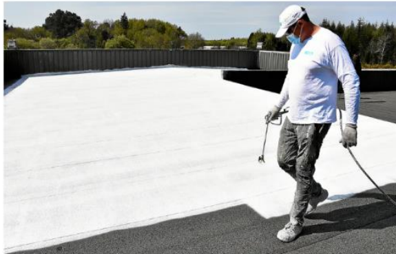
Un homme peint en blanc un toit. Une peinture réfléchissante à base de coquilles d'huîtres mise au point par Cool Roof France, à Brandérion (Morbihan). (MAXPPP)
